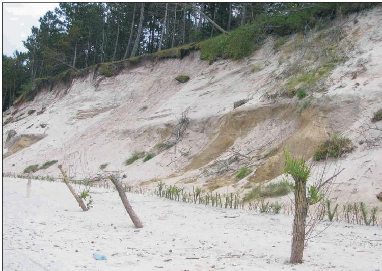
Rys. 1. Fragment klifu w pobliżu miejscowości Pleśna Fig. 1. Part of cliff in the vicinity of Pleśna
