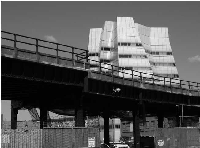
Fot. 2. Nadziemna linia kolejowa przed rewitalizacją (fot. W. Gadomska)
