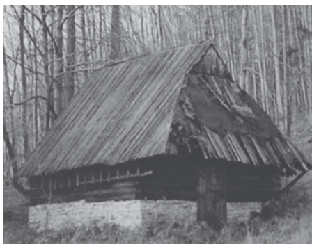
Typ II A. Szopa drewniano-kamienna (niskozrębowa) wooden-stone shed (low log structure)
