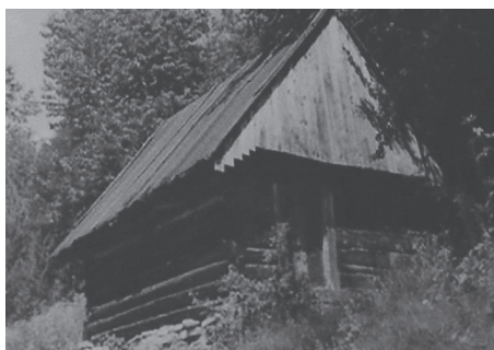
Typ II B. Szopa drewniano-kamienna (wysokozrębowa) wooden-stone shed (high log structure)
