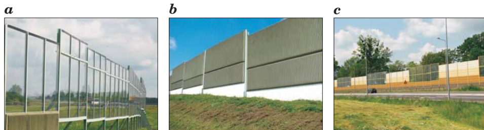
Rys. 1. Ekran akustyczny: a – akrylowy, b – aluminiowy, c – trocinobetonowy (fot. K. Kocur-Bera)
