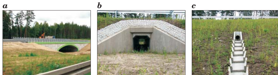
Rys. 4. Przykłady przejść dla zwierząt: a – dla zwierząt dużych (dolne), b – dla zwierząt średnich (dolne), c – przejście dla płazów i gadów
