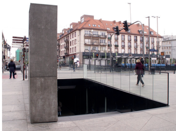
Rys. 3. Podziemno-naziemne Przejście Świdnickie
